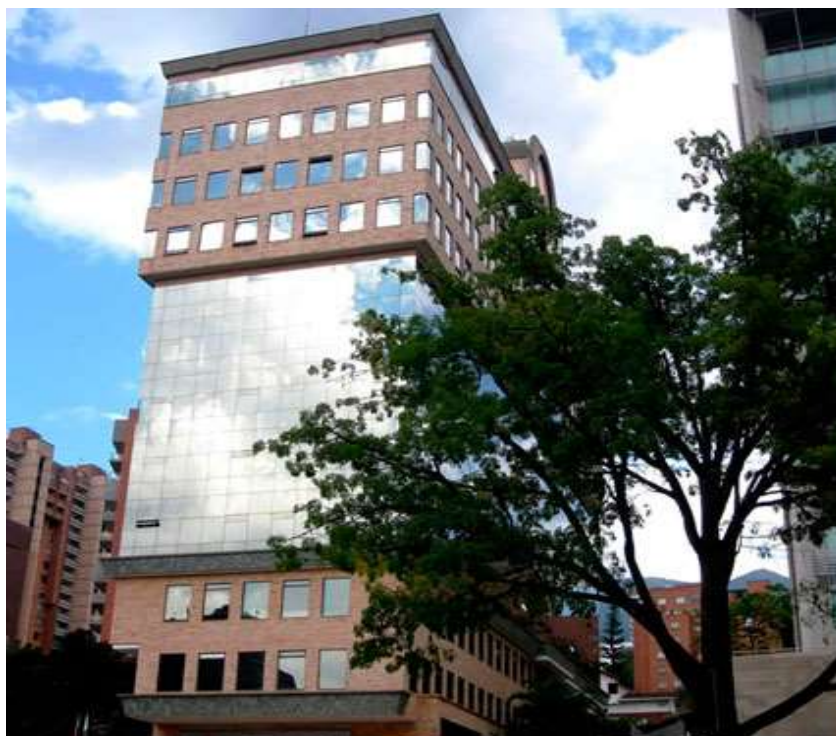
TORRE EMPRESARIAL DAVIVIENDA PH.
